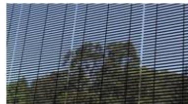
BIPVガラス (建物一体型太陽光モジュール)
