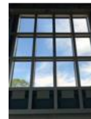
BIPVガラス (建物一体型太陽光モジュール)
