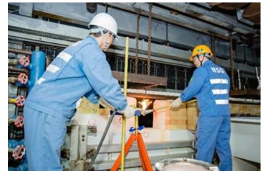
ベトナム工場の全景と火入れ式の様子
