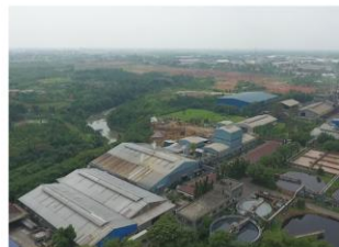
インドネシアJV 新工場予定地
